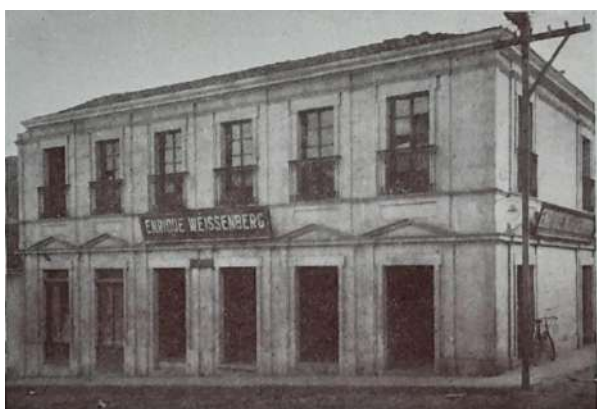
Fig. 13. Almacén de Enrique Weissenberg, Quetzaltenango. Libro Azul de Guatemala, 1915: 295. Nótese la obra material en la edificación.
