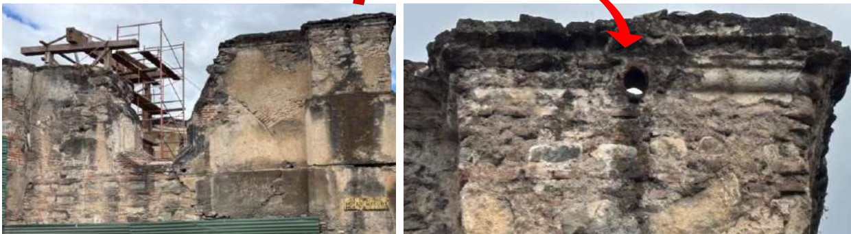
Fig. 4. Gárgola de cerámica en la fachada del antiguo templo del Beaterio de Indias Fotografía: B. Cruz
