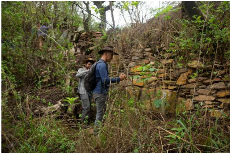
Fig. 10. Véase la combinación de las lajas y en la parte inferior bloques in situ que fueron utilizados para construir la muralla (fotografía: PARBEZ, 2024).
