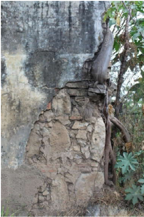
Fig. 4. Detalle de la mampostería de calicanto en la Finca Belén, Amatitlán. Fuente: J. Cáceres, 2022.
