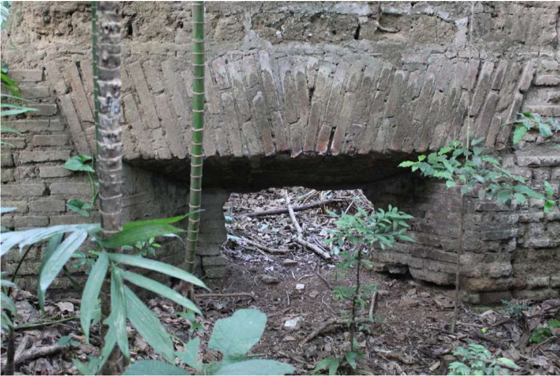
Fig. 12. Detalle de la composición de un dintel y los derrames en un vano parcialmente soterrados. ITUGS, Palín. Fuente: J. Cáceres, 2021.
