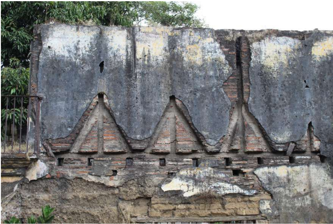
Fig. 6. Detalle del entrepiso y la técnica para erigir los muros de planta alta. Finca Belén, Amatitlán. Fuente: J. Cáceres, 2022.
