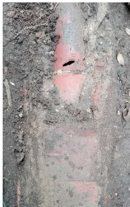
Figura 16 Tubo de barro en el interior de la caja de ladrillos, obsérvese el orificio en la tubería. Fotografía I. Fajardo, 2023.
