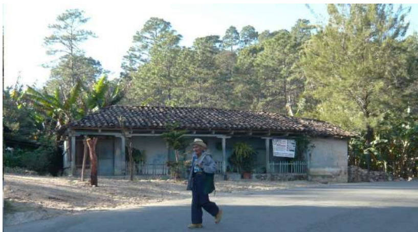
Figura 7. Fachada principal de viviendas en las comunidades referidas. Nótese la forma y el uso del adobe, las tejas y la madera. Fuente: J. Cáceres, 2010.
