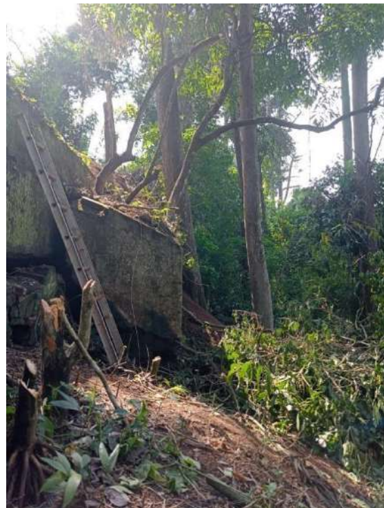
Figura 34 Contrafuerte en la sección oeste del Acueducto de Pinula. Fotografía R. Vásquez 2023
