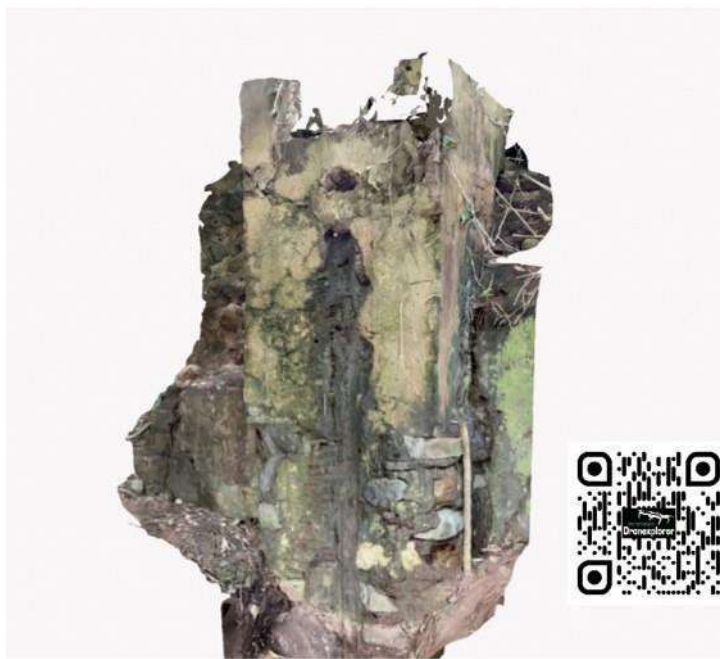
Figura 20 Modificación en la superficie de la caja de distribución de agua, al cortar un canal exterior. Fotogrametría Patrimonio Dronexplorer, 2023. Enlace: https://skfb.ly/oNCMP
