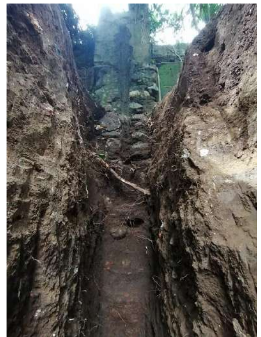
Figura 19 Perfil sur TE-8, caja distribuidora de agua del acueducto. Fotografía I. Fajardo 2023
