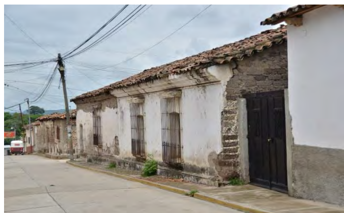
Figura 14. Ejemplo de voladizo en remate de cabeza de muro. (Fotografía: Atlas de Jalapa, 2017)
