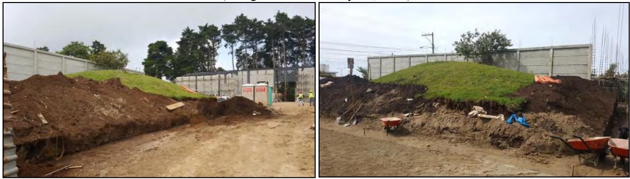
Figura 19. Restitución de volumen de manera manual, usando palas y carretillas. (Fotografías: A.L. Arroyave, 2018)
