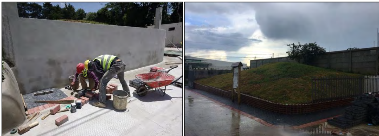
Figura 21. A la izquierda se muestra el muro del lado este que se levantó al exterior del montículo. El mismo es diferente ya que es el que da a la calle por lo que tiene que ser más alto y seguro. También se muestra cómo fue colocado el adoquín de la banqueta peatonal alrededor del montículo. A la derecha se ve la banqueta ya colocada en su totalidad, nótese el detalle del ladrillo y colocación del panel informativo y verja, la cual se fabricó allí mismo. (Fotografías: A.L. Arroyave, 2018)
