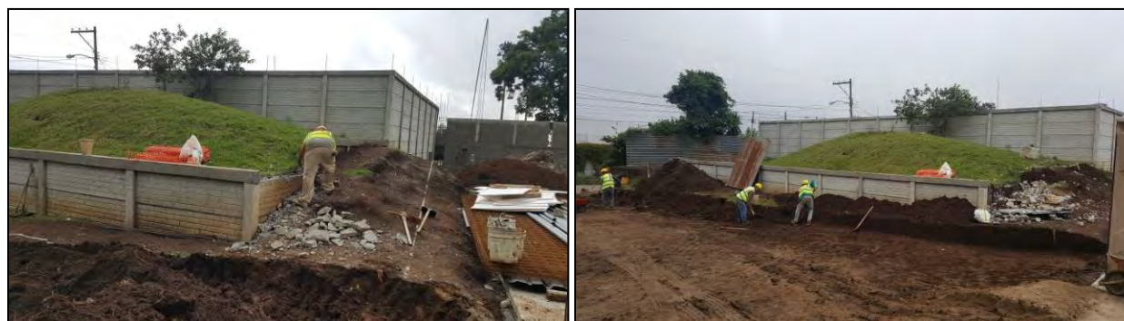
Figura 17. Retiro manual de muro perimetral paliativo. (Fotografías: A.L. Arroyave, 2018)
