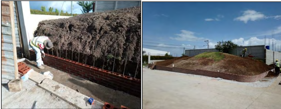
Figura 20. Levantado de nuevo muro perimetral hecho de ladrillo, nótese la restitución de volumen del montículo. Para una mejor estética el muro se redondeó en la esquina noroeste y se hizo escalonado, se trazó la banqueta peatonal alrededor. (Fotografías: A.L. Arroyave, 2018)
