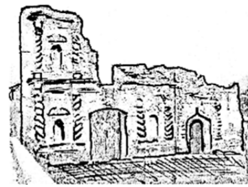
Figura 10. Templo arruinado de N.S. de Candelaria. A mano derecha se observa una puerta, era la entrada a la capilla de Jesús Nazareno.
