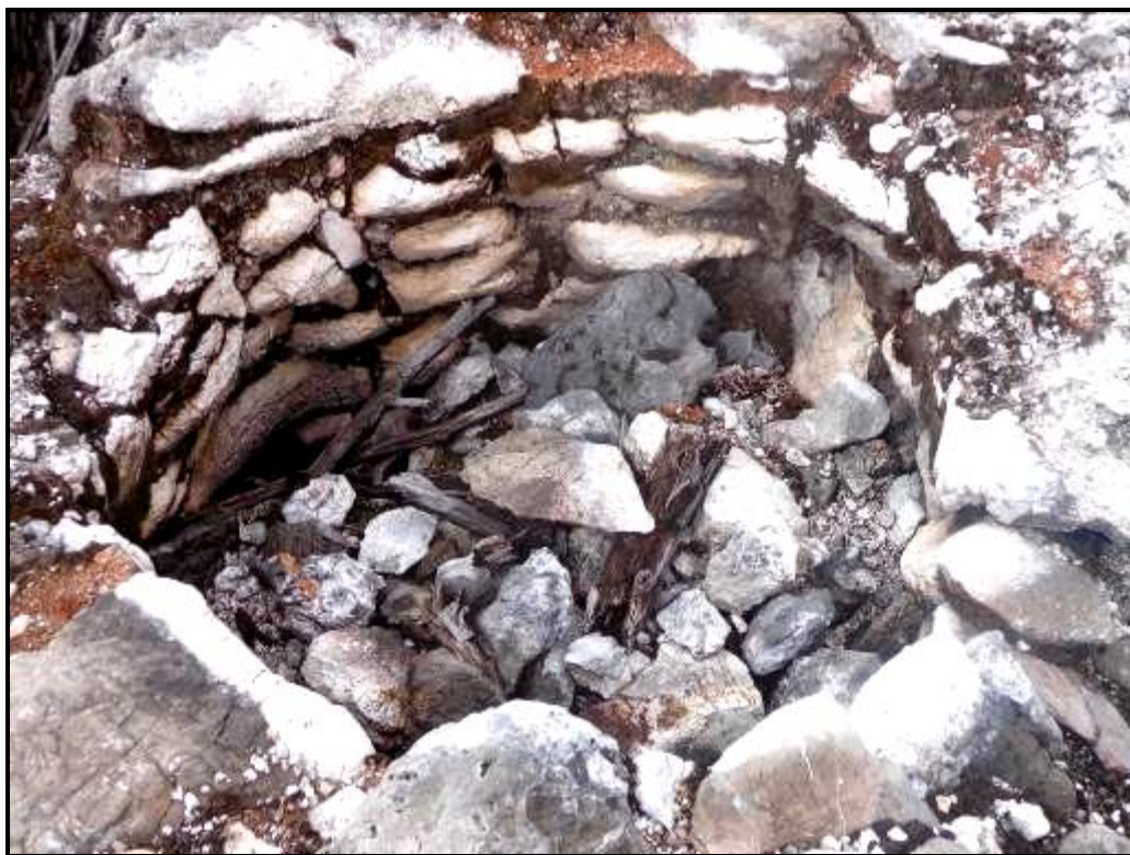
Figura 7. Parte central del horno donde se colocaban las piedras que eran quemadas para producir cal.
